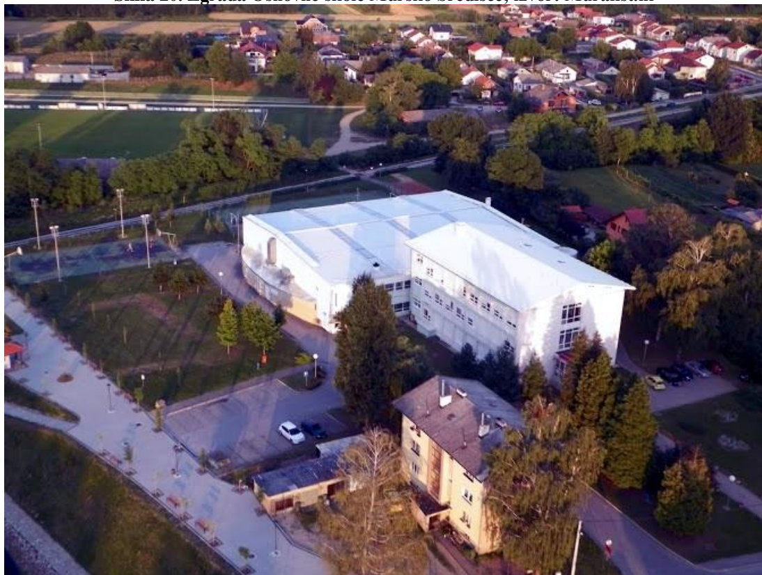
Slika 20. Zgrada Osnovne škole Mursko Središće; izvor: Muralist.hr
