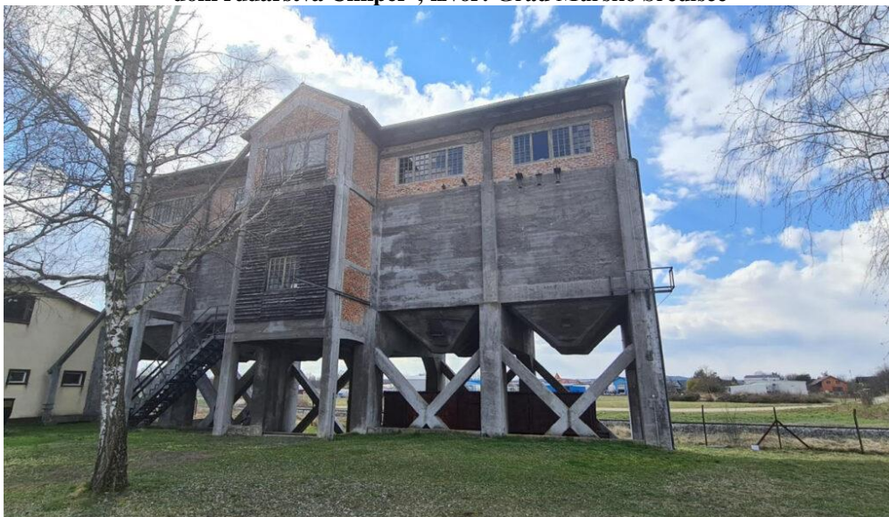
Slika 8. Nekadašnji separator ugljena u Murskom Središću, danas Zabavno-edukativni centar ‘Spomen dom rudarstva Cimper’; izvor: Grad Mursko Središće
